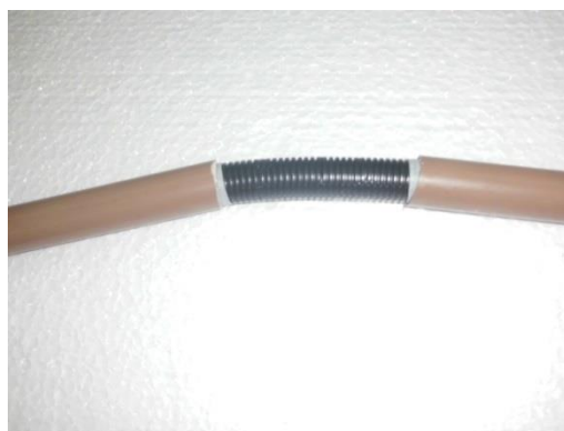
Figura 8. Caño corrugado introducido en la cabeza.
